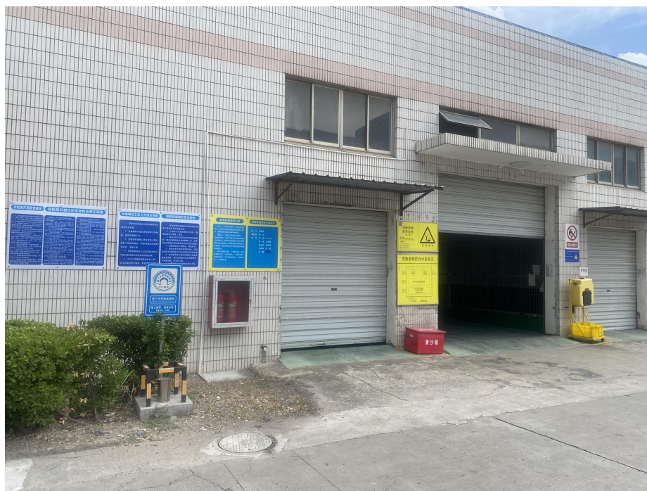
图5.1-12 危险废物仓库外部
