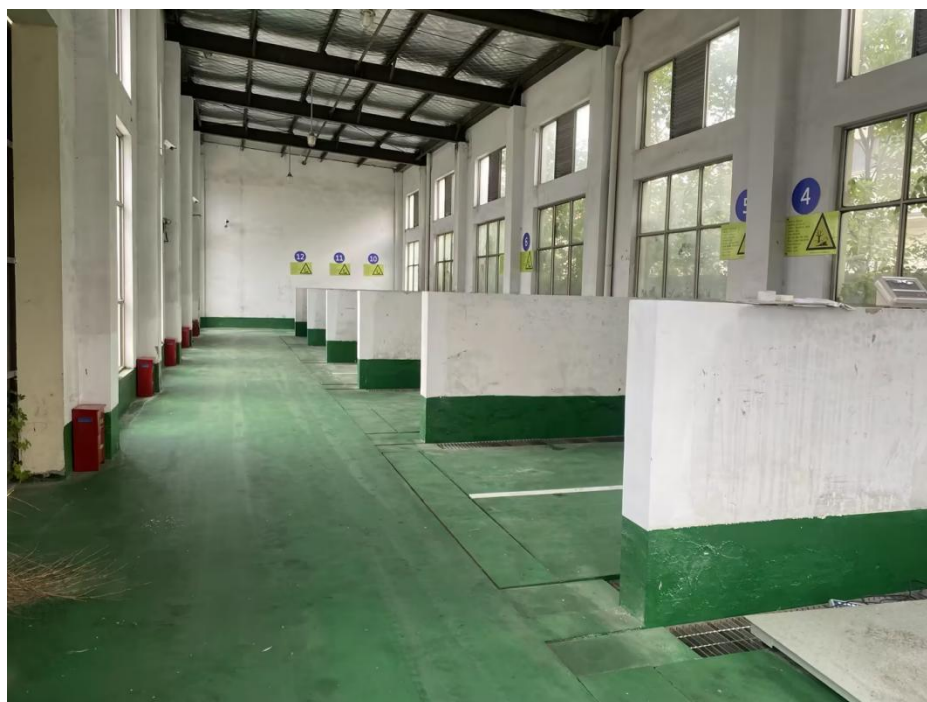
图5.1-12 危废仓库内部
