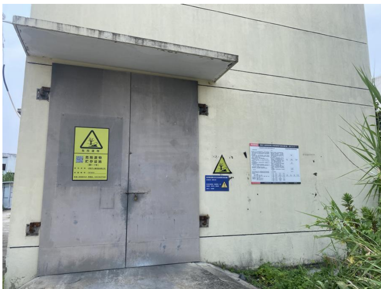
图5.1-11 危废仓库外部
